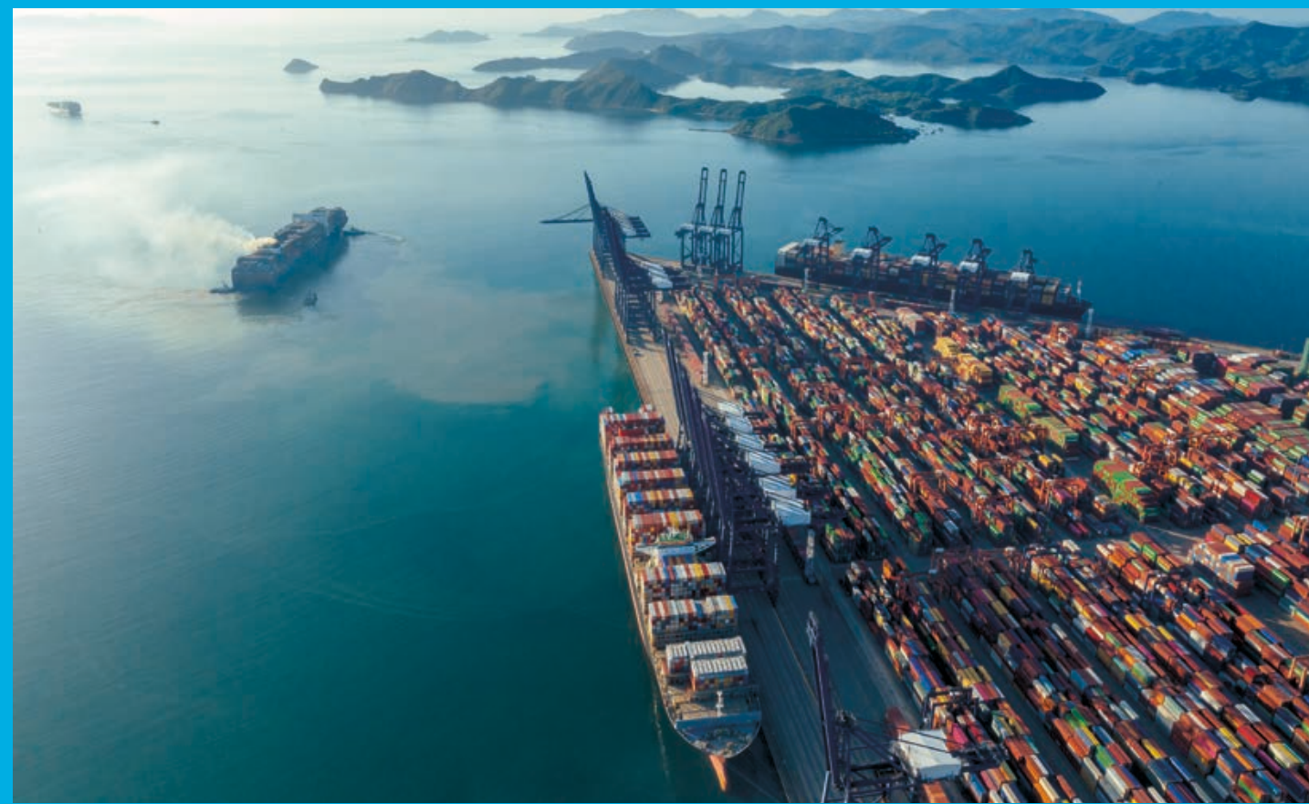
(1) 深圳鹽田港。 Port of Yantian, Shenzhen.
