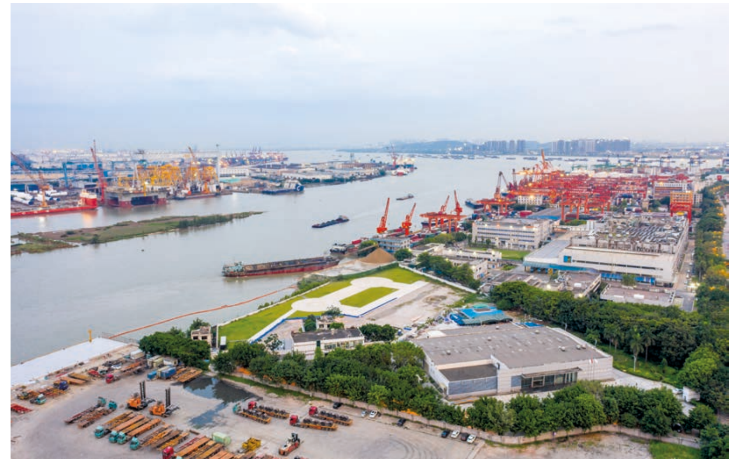
23.3 廣州港·廣州。 Guangzhou port, Guangzhou.
