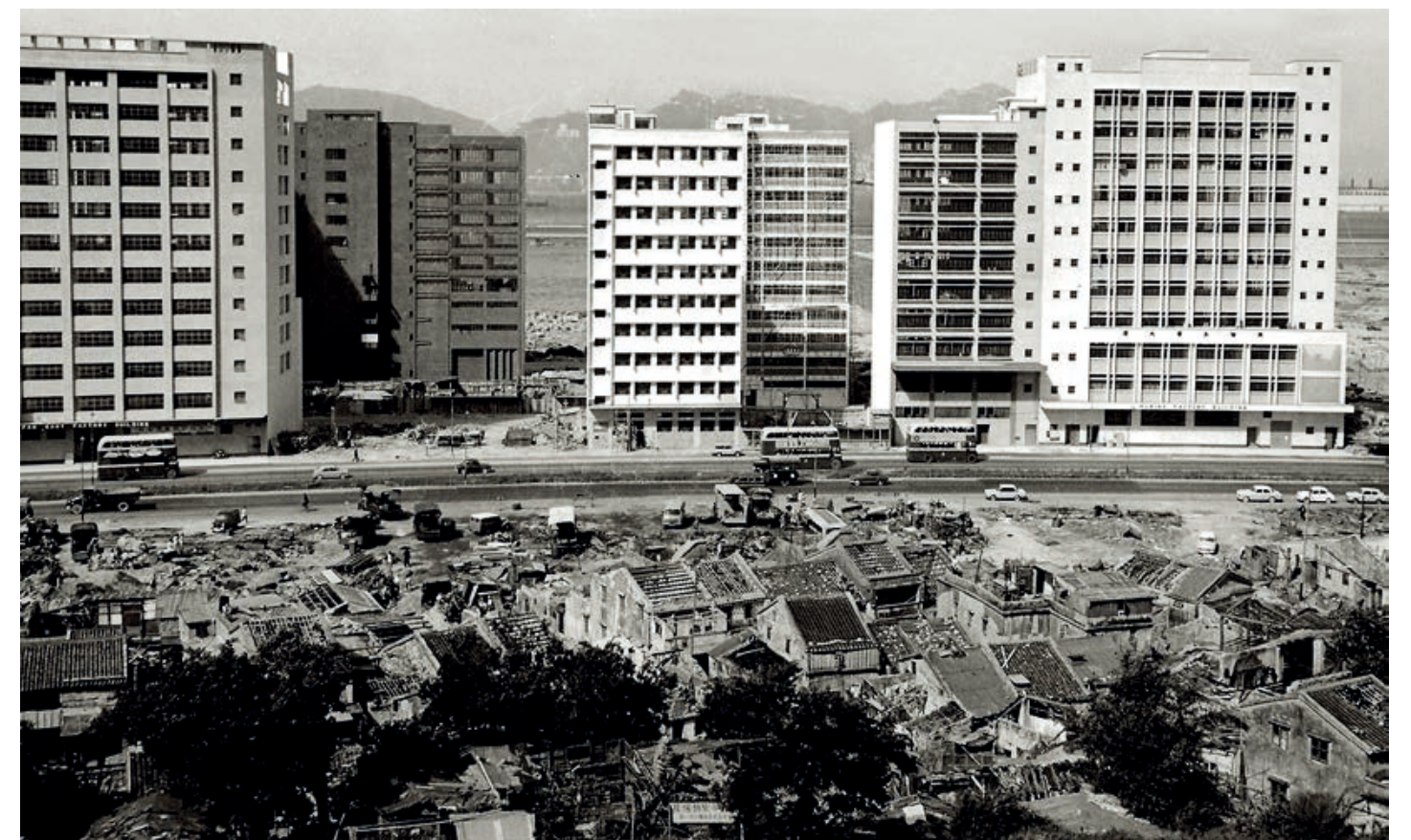
9.2 1966年於牛頭角村新建成的工廠大廈。 New factory buildings rising above the villages of Ngau Tau Kok, 1966.
